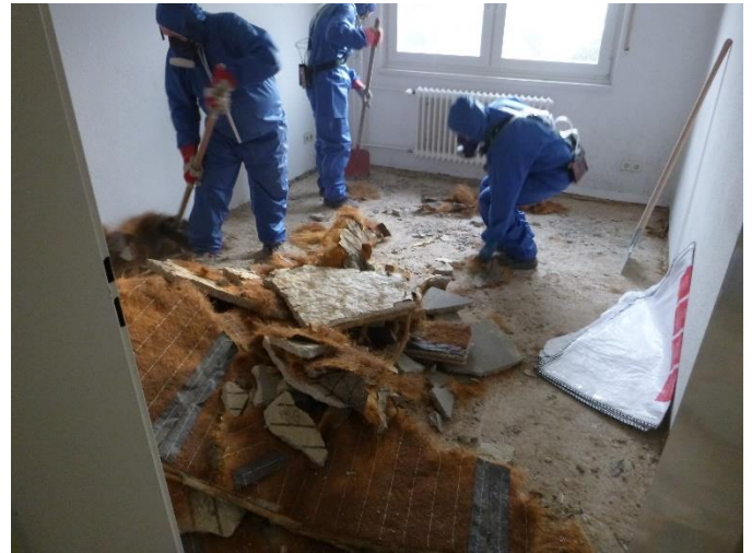
Bild 2: Separation asbesthaltiger Bodenaufbau vor Abbruch
