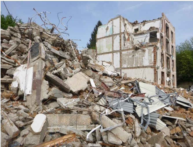
Bild 1: Abbruchmaßnahme mit Anfall von Recyclingbaustoffen
